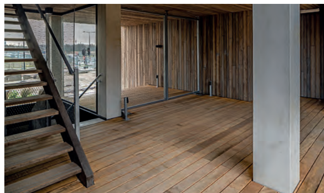
De houten galerijen zijn biobased en demontabel en dragen daarmee bij aan het circulaire karakter van het gebouw.
