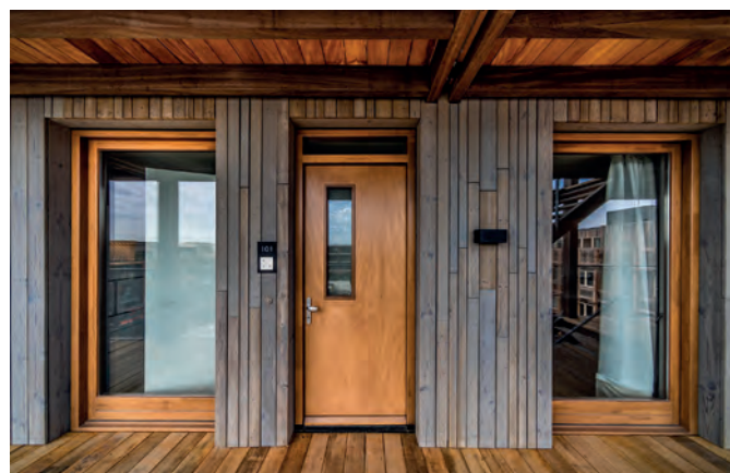
De houten galerijen zijn biobased en demontabel en dragen daarmee bij aan het circulaire karakter van het gebouw.
