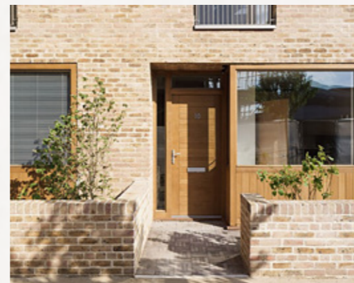
Overgangszone aan Dunantstraat door plantenbak
