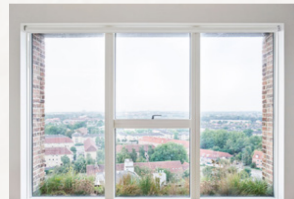
Plantenbakken bij onderzijde raam
